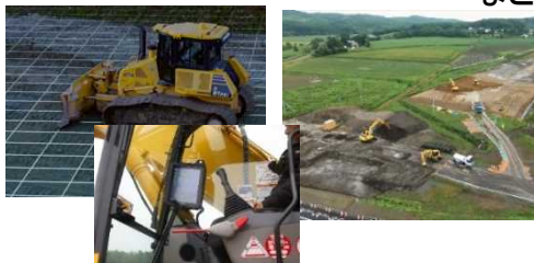
ICT建機での施工
